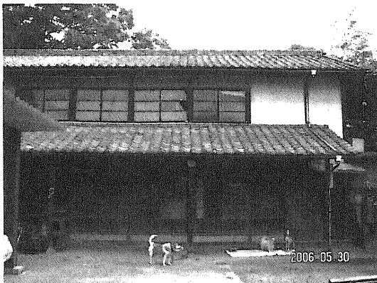
写真1 大下集落の農家に残る養蚕小屋 (2006年、5月星撮影)
