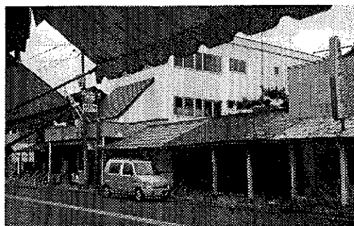
写真5-4 シャッターの開かない店舗群
