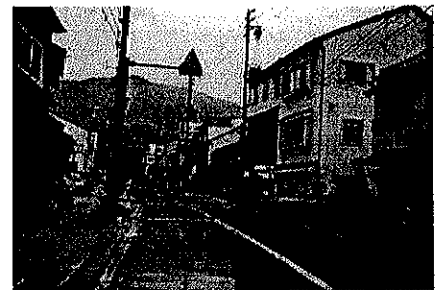
街路拡幅と共に町並み整備を行った商店街(写真1)
