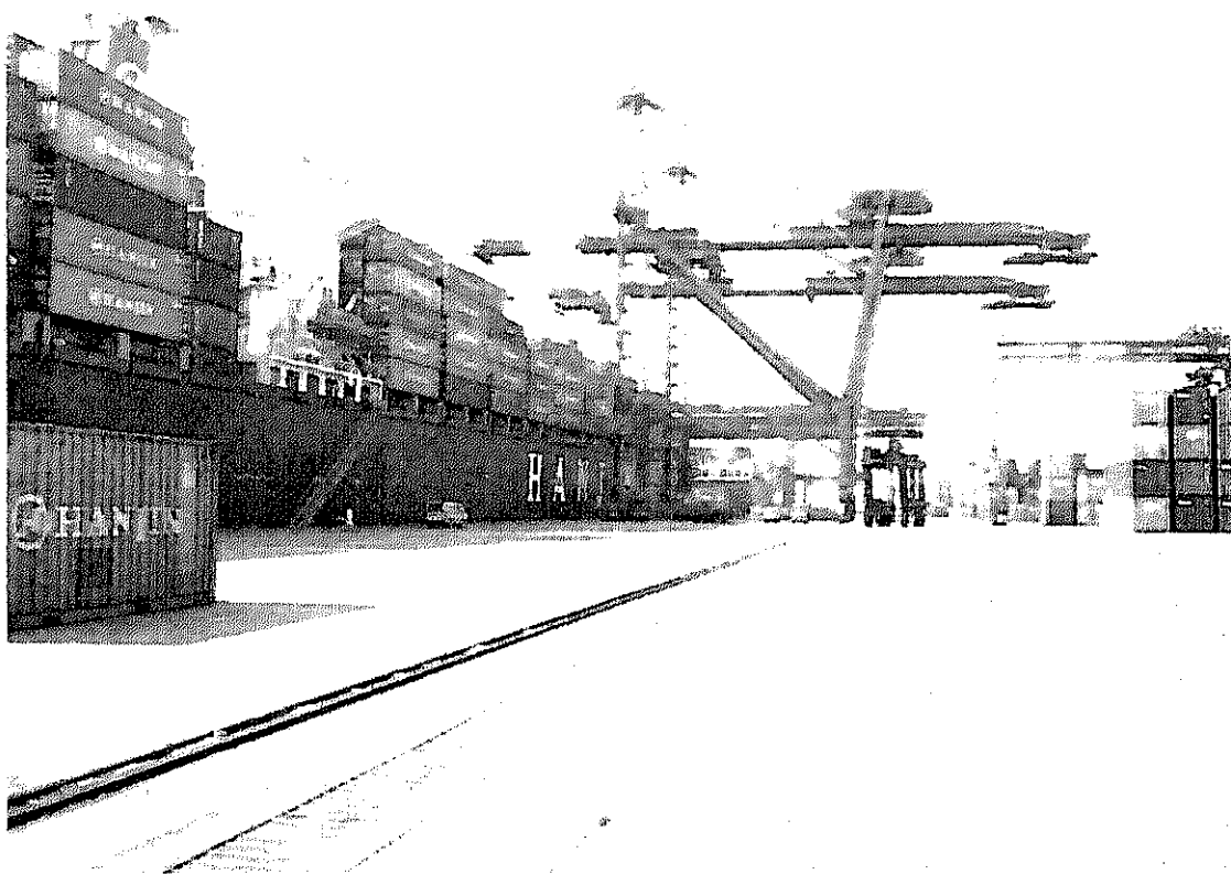
写真-2. 1. 1 コンテナクレーン全景
