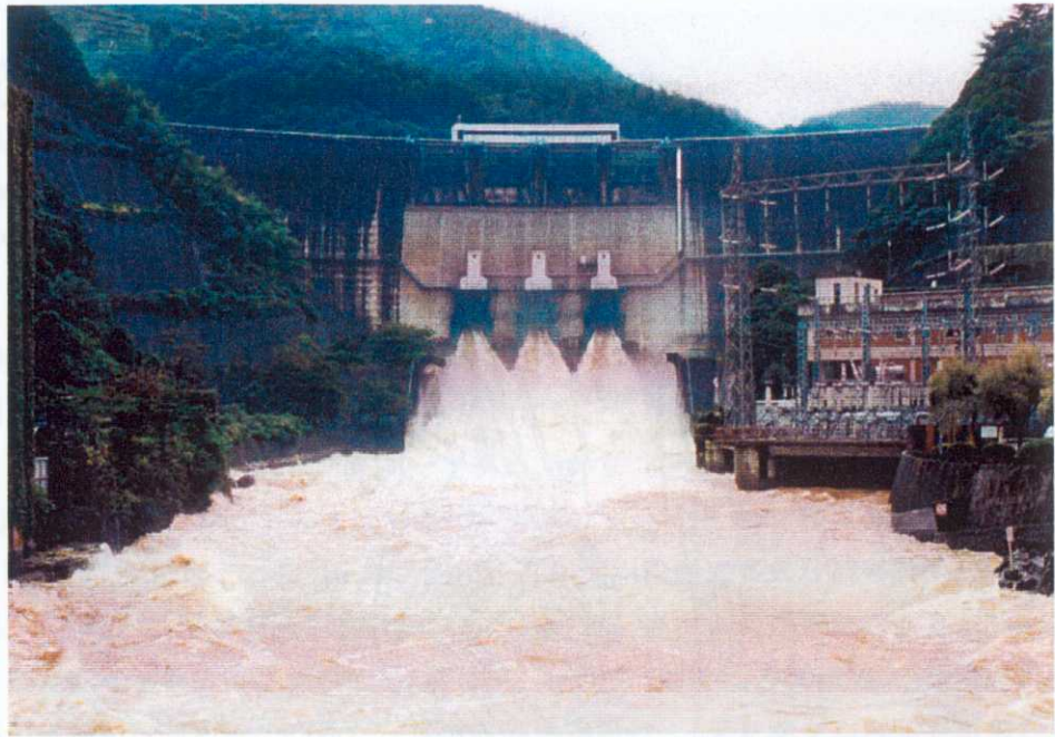
写真-5.2 天ヶ瀬ダム放流状況
