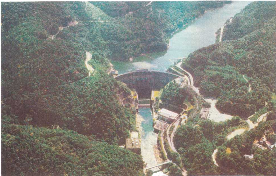
写真-5.1 天ヶ瀬ダムの現況
