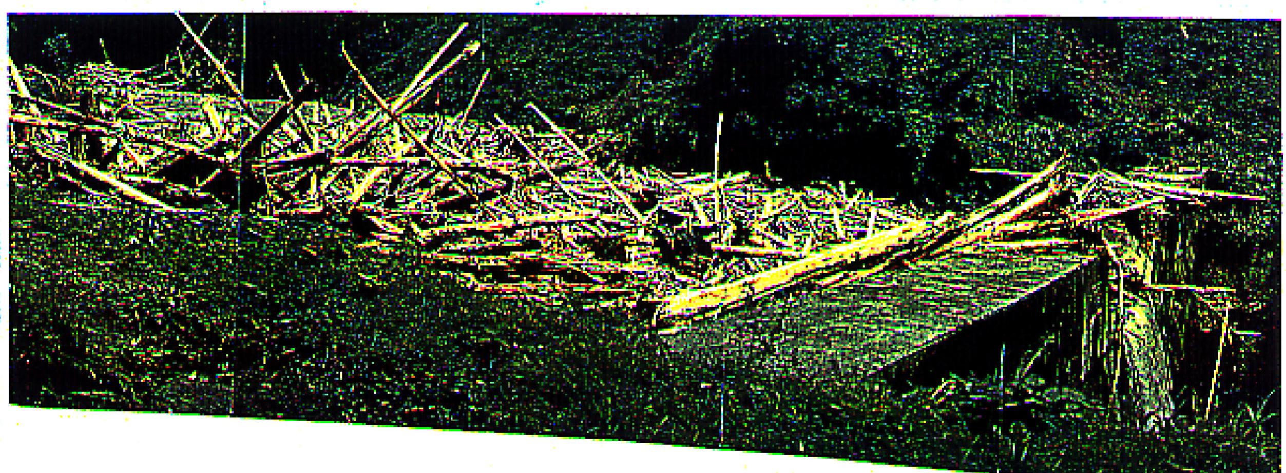
写真 3.8 満砂状態の不透過型砂防ダムによる流木捕捉状況
