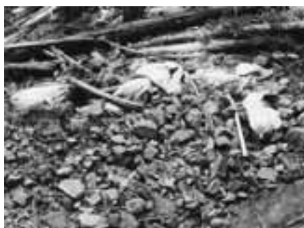
写真4 土石流の堆積物。折れ曲がったセンサー(右)や鉄製水路(左)が見えます。
