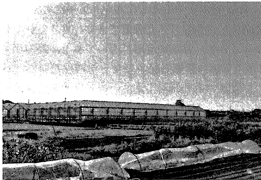
写真2 下ノ原の施設団地 硬質プラスチックハウスやガラスハウスは主に施設団地内に建てられている。これらのハウスは静岡型のハウスに比べ、面積が広く高さもある。また、温度調節や灌水など自動で行う所がほとんどである。
