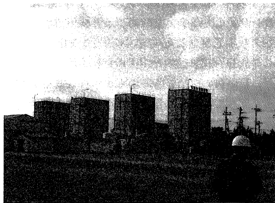
写真4 ブローイングアウト法によるヨード採取施設
