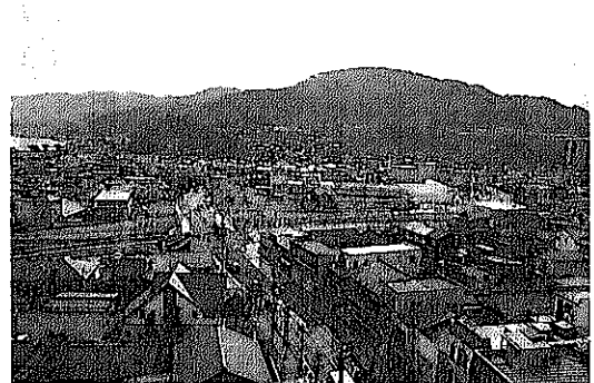
写真13 市営駐車場からみた中央本線南部と丸山タンク (2004年12月7日撮影)
