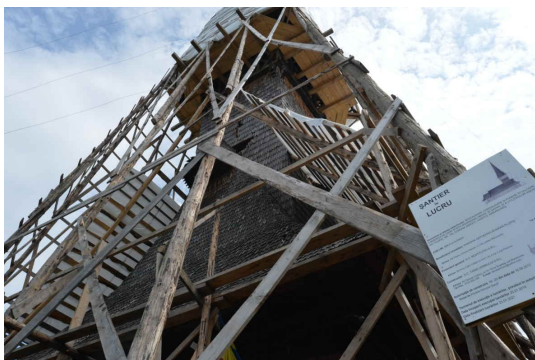
図 13. 修理中のプロピス教会堂
