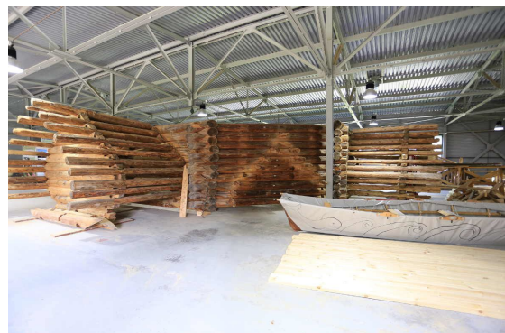
図 2. 作業場での仮組み
