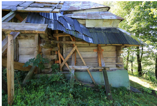
図4. 斜面に建つロニ教会堂
