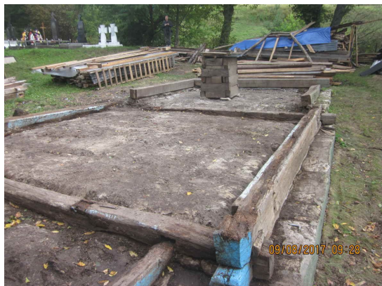
図5. 解体の状況 アンドリー氏
