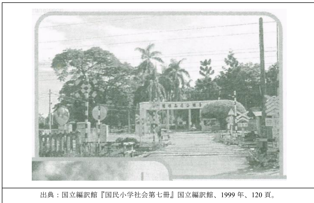
図 4.6.5 高雄橋頭砂糖工場
