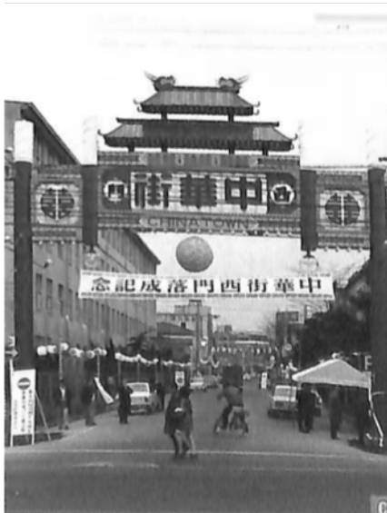
写真-4 西門(1970年建設) 26)
