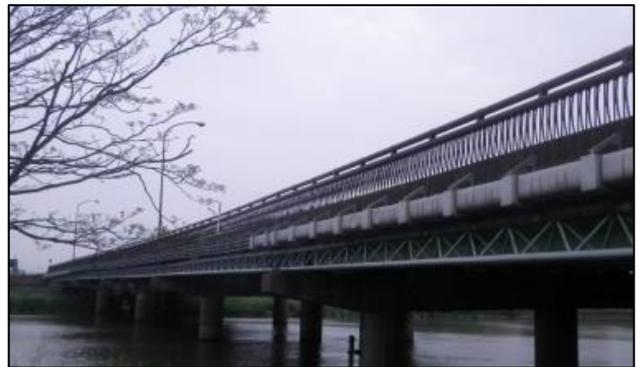
図-2 専用橋の例(トラス)
