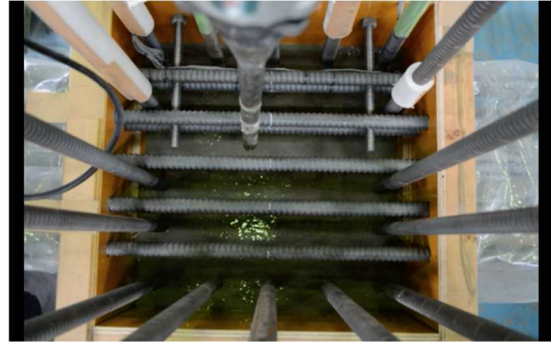
2) Insert vibrator rod
