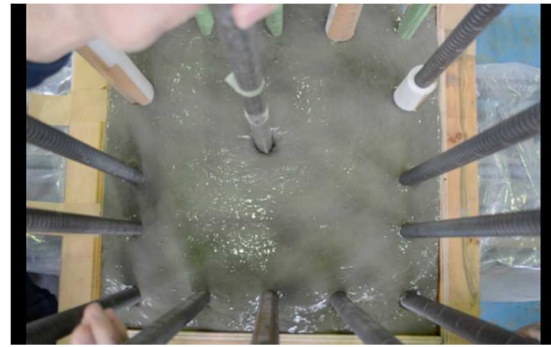
4) Insert vibrator rod
