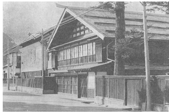
写真 3-3-2 金山町における伝統的な町家住宅の外観（参考文献 13 より引用）
