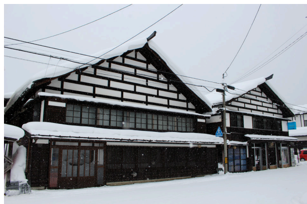
写真 1-4-3 金山町の町並み (2018年1月撮影)
