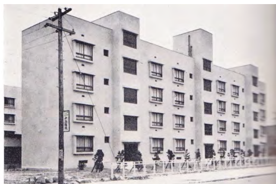
図 3-3 兵庫県公営住宅 51CN 15)
