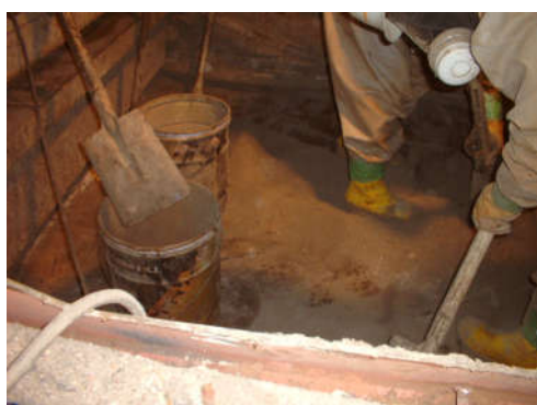
図 2.2 堆積物の回収状況（除染前）
