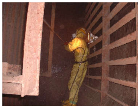
図 2.3 除染作業状況
