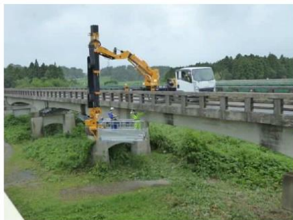
写真5-1 橋梁点検車(BT200)による点検作業(幸久橋)
