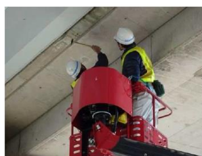
写真5-2 作業台車(リフト車)による点検作業(蒲原高架橋)
