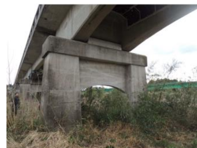
コンクリート製橋脚部
