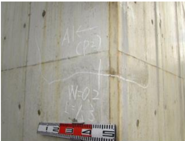
写真7-1 人が撮影したひび割れ(左)とロボットが撮影したひび割れ(右)違い ～ 一見ただけでは、同一のひび割れと認識することは難しい。～
