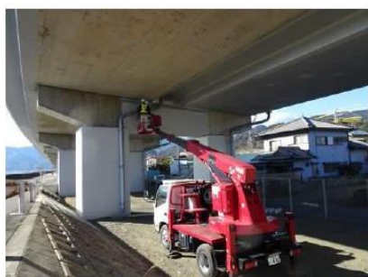
写真5-2 作業台車(リフト車)による点検作業(蒲原高架橋)
