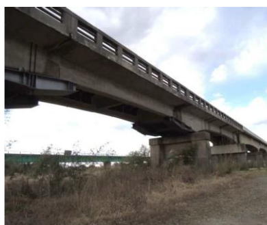
コンクリート桁部
