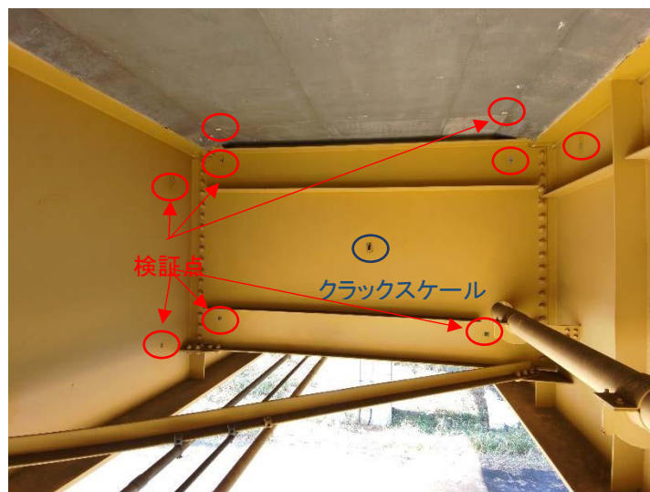
写真 7-5 桁内部に設置した検証点とクラックスケール
