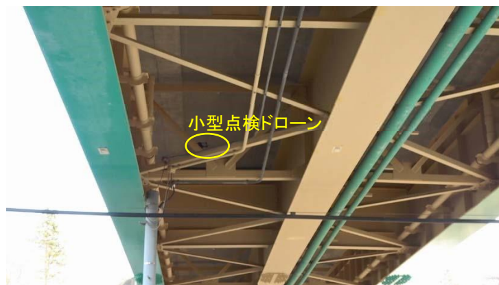
写真7-6 桁内狭隘空間の点検する飛行型点検ロボットの例
