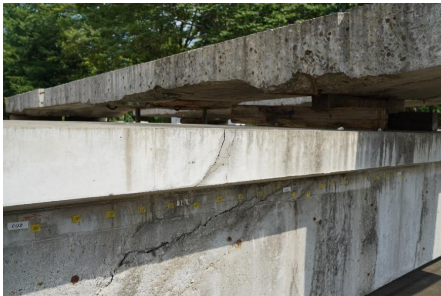
写真6-4 クラックの撮影を行った土木研究所内の実橋梁カットモデル
