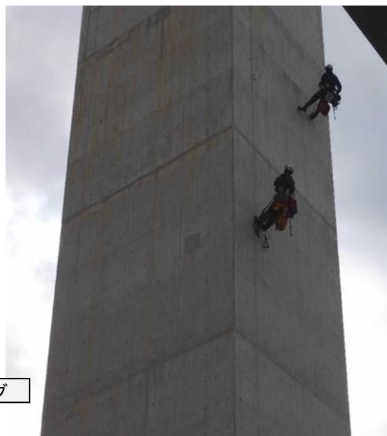
写真6-2 高所特殊技術による点検の様子
