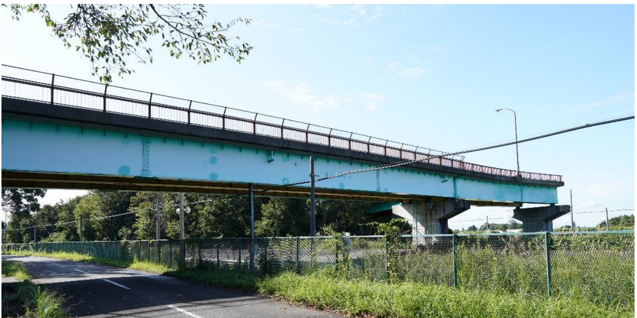
写真6-12 検証対象橋梁(2径間連続鈹桁橋:橋長=40m,幅員=8m,高さ=7.5m(土木研究所内))
