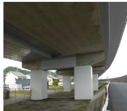
床版橋下面の様子
