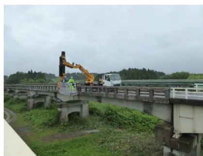
写真5-1 橋梁点検車(BT200)による点検作業(幸久橋)
