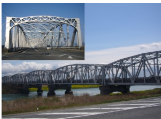
図4-15 大垣市景観遺産（近代遺産）：揖斐大橋
