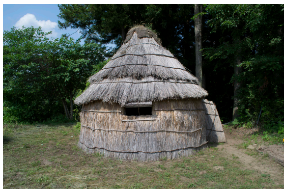
図 5-20 「山口デンデラ野散策道整備工事」によって住民が作成した東屋
