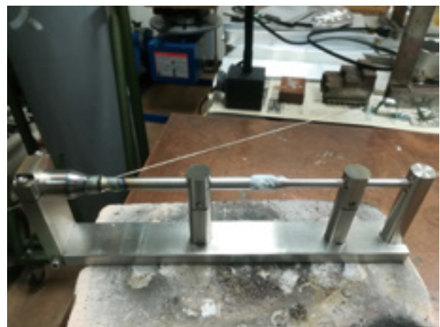
図4. 溶接作業風景
