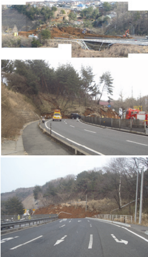
図-6 上から、排土作業中の全景, 国道4号線北側, 国道4号線南側の被害直後の様子, 日本大学中村晋教授提供
