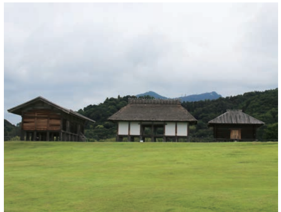
復元された「板倉」(左)、「土倉」(中)、「校倉」(右)(6月9日、平沢官衙遺跡歴史ひろばで) = 西村大祐撮影
