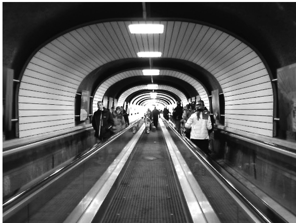
(a) ドルフトンネル
