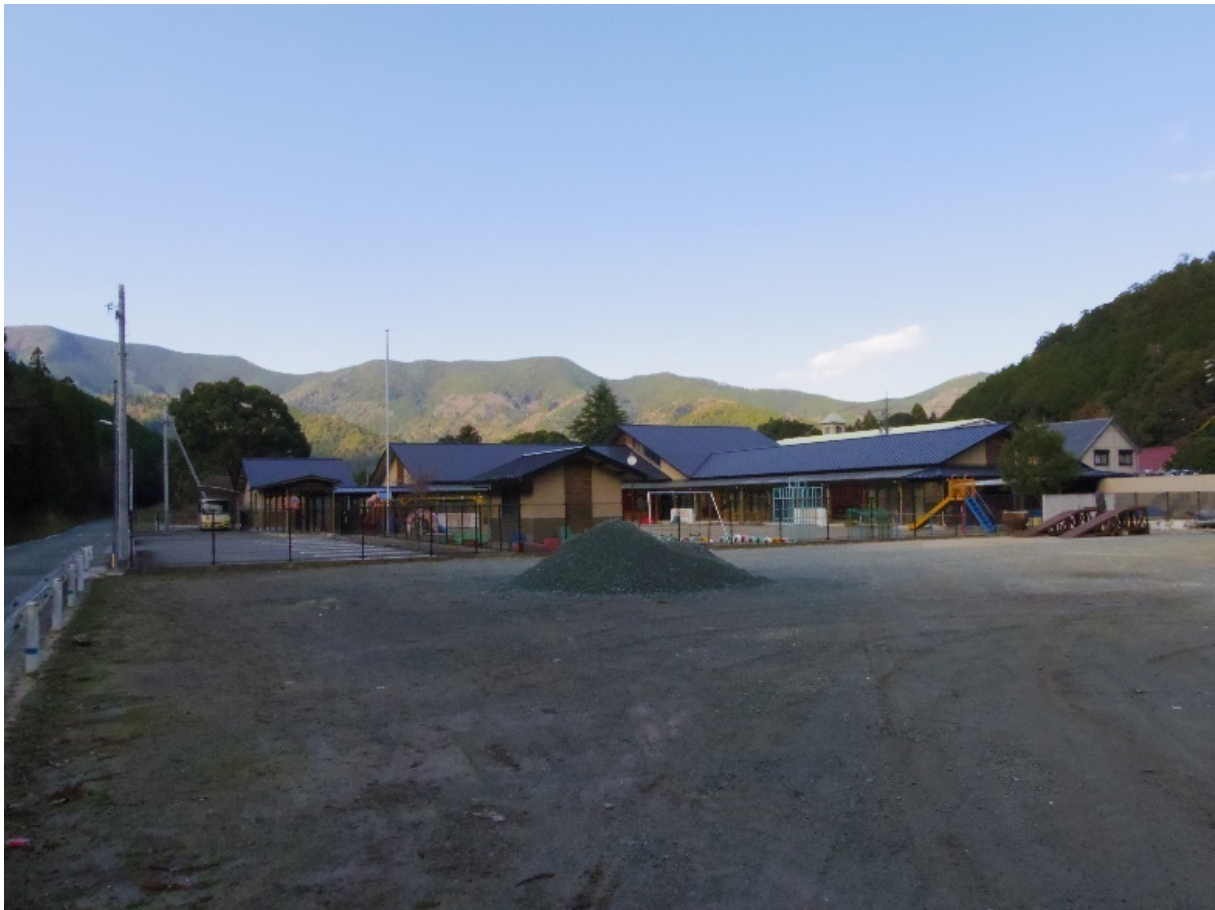
図 48 長者屋敷付近現況
