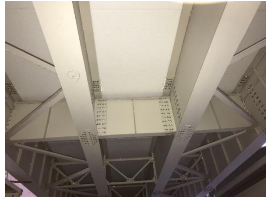
(d) Horizontal girder
