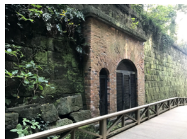
写真3 遺跡内の煉瓦造構造物
