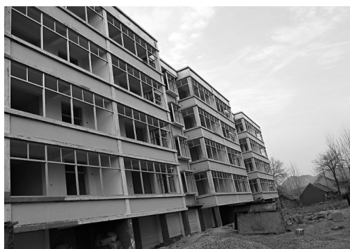
写真3 新しく建てられたビル
