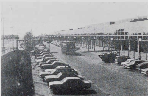
写真10 中央ミルトン・キーンズのショッピング・ビル。2階の壁面の一部は、ガラスと鏡でできており、自然採光が取り入れられている。内部の通路は、樹木や草花で飾られている。
