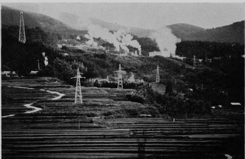
写真11. 大岳地熱発電所(1981年8月)
