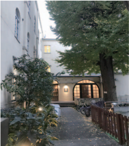
写真.求道学舎外部
