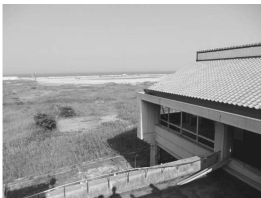
図2 旧中浜小学校の屋上から
