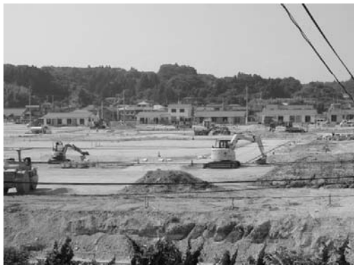
図1 建設中の坂元新市街地
