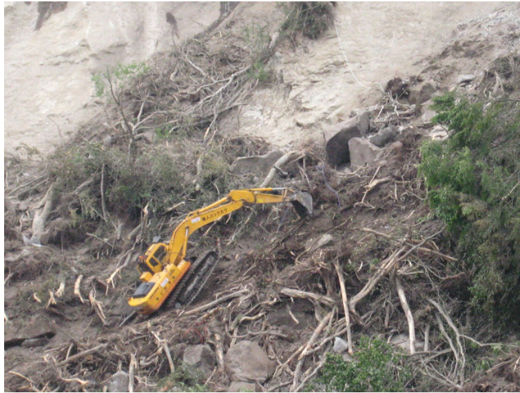
図 1.1: 急傾斜地において遠隔操縦油圧ショベルが土砂撤去を行っている様子 (栗原市より提供)
