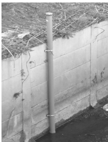
図 3-4 水位・水温計設置完了後の写真
