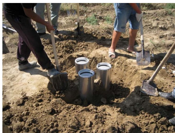
写真 6.3.2 円筒体の取り出し状況
