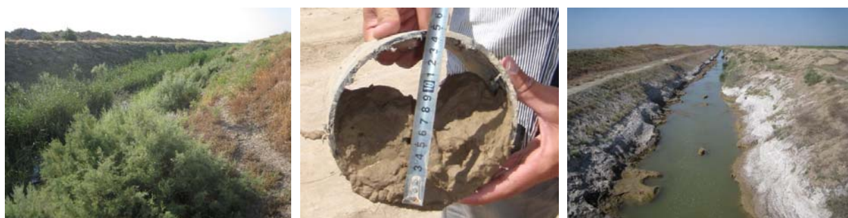
写真 2.3.1 ミルザバッド地区内の明渠排水路（左）、土砂堆積した暗渠管（中）、中央幹線排水路（右） （写真中は奥田幸夫氏提供）
