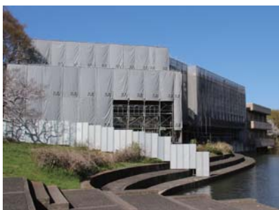
筑波大では現在も耐震改修工事が進む(3月30日、第一エリアで) = 秋田耕平撮影
