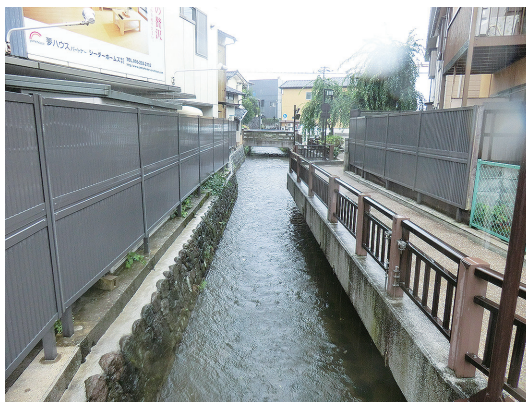
写真2 住居裏に新たに設置された張出歩道2 (2014年8月著者撮影)
