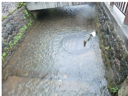
写真5 用水底に設けられた防火用ピット (2014年8月著者撮影)
