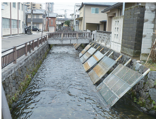
写真9 用水に設置された消雪板 (2015年12月著者撮影)
