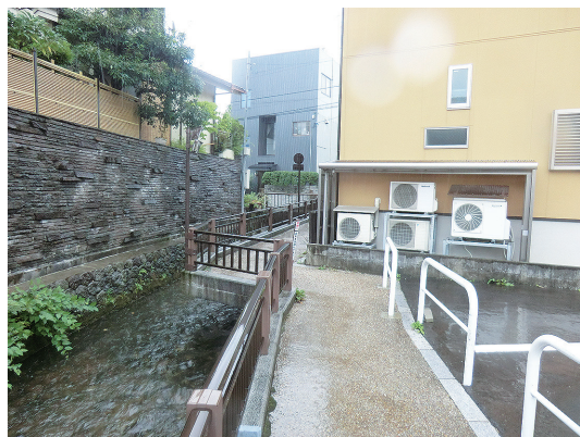
写真1 住居裏に新たに設置された張出歩道1 (2014年8月著者撮影)
