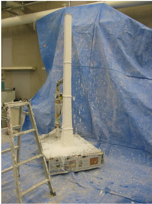
図 4-95 石膏取りの作業（肌つけ）
