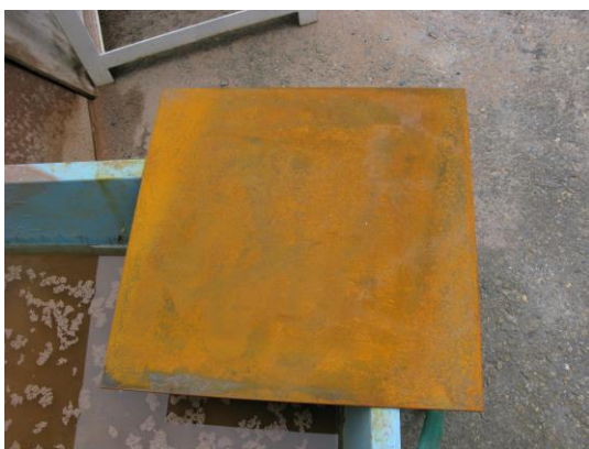
図 4-132 鉄板の表面処理
