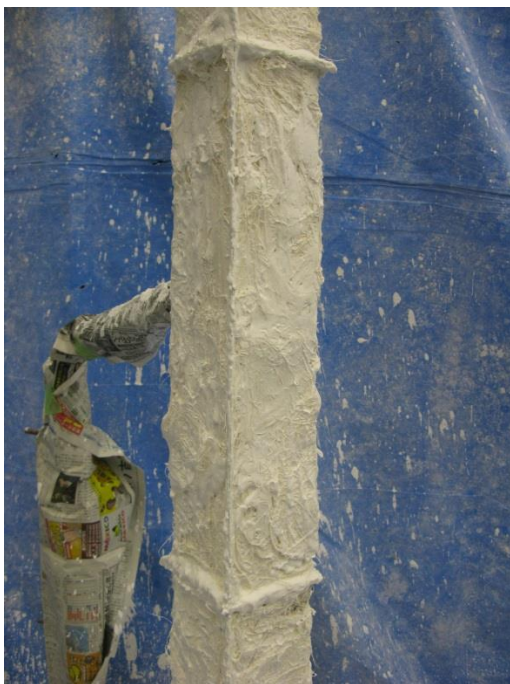
図 4-96 石膏取りの作業（補強）
