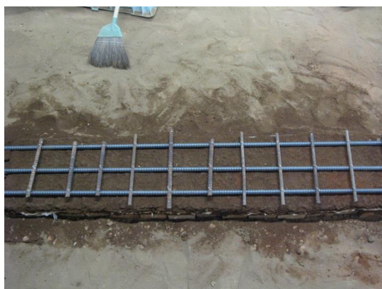
図 4-67 筋金で補強
