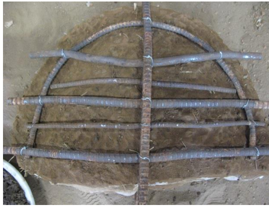
図 3-32 筋金で補強
