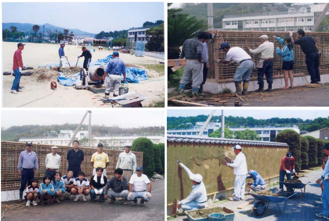
写真 11：実際の建設風景 (撮影：宇城市立不知火中学校)
