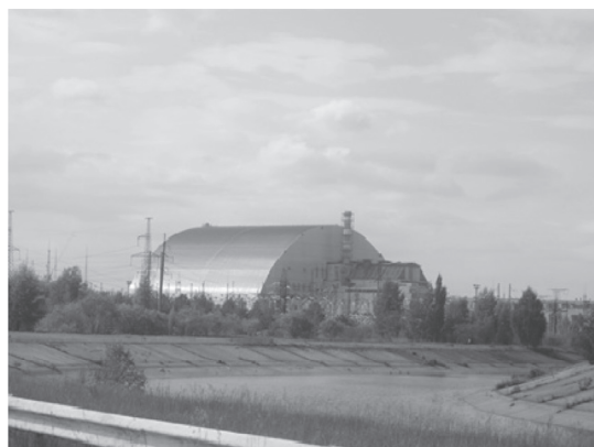
第1図 巨大シェルターの移設作業終了後のチェルノブイリ原子力発電所（2017年6月1日撮影）。
