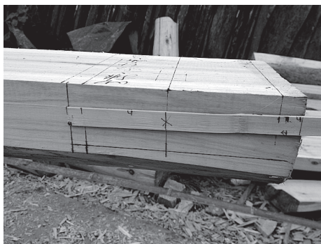
写真4 短竹尺と墨付けられた仕口
