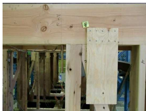
図 3.14 筋かいの外れ止
