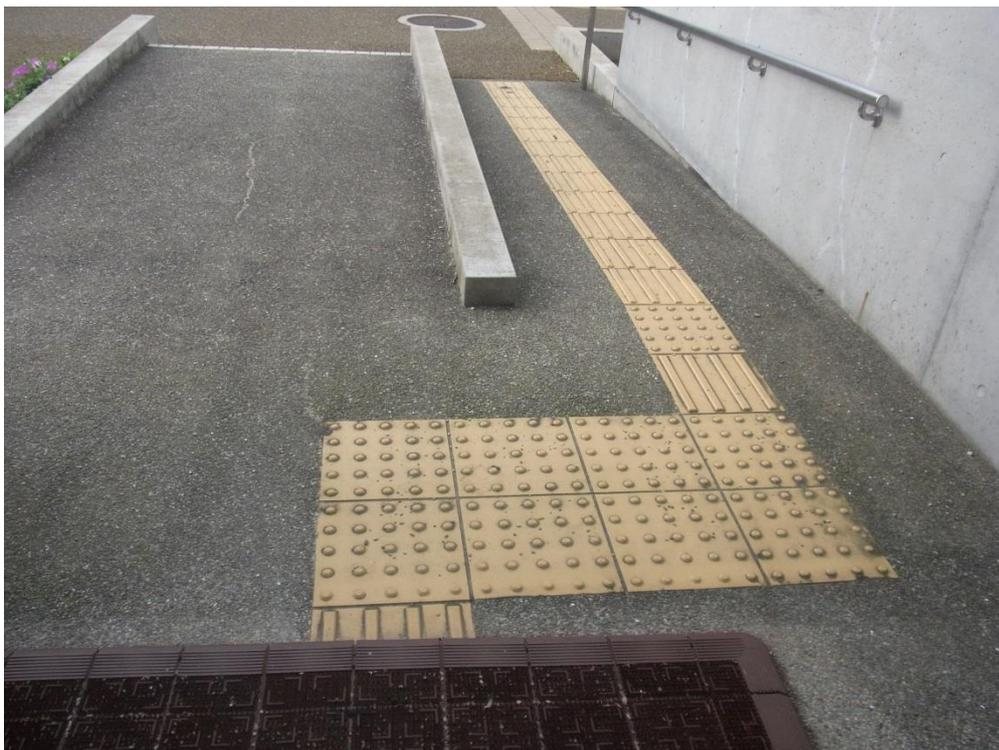
写真 4-1-6 : 建物の入り口に続くスロープの真ん中に点字ブロックが設置されている（玉村町北部公園）
