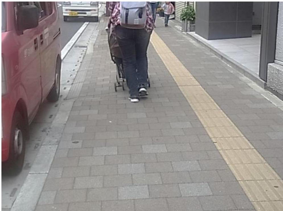
写真 4-2-55 : 車道に流れる傾斜があり、ベビーカーを操作しにくい歩道 (高崎市八島町)
