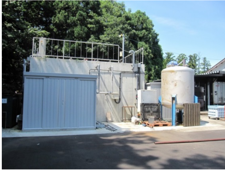
写真 2 - 3 排水処理施設全体
