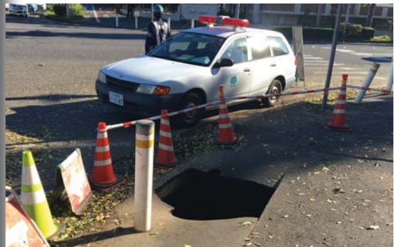
陥没した路面の地中には深さ約4桁の空洞が広がっていた (10月30日、東大通りで) = 田中間 (教育学類4年) 撮影
