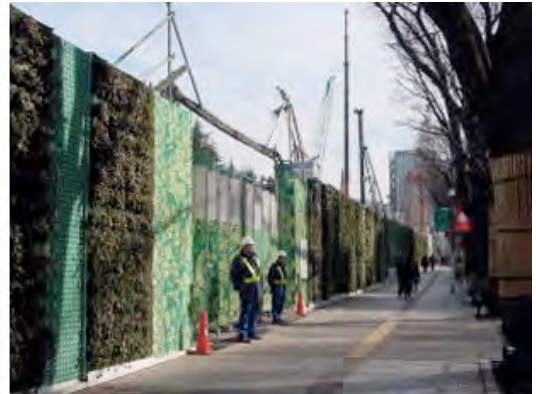
図4-3-19) 旧同潤会青山アパートのリニューアル現場の仮囲い*
