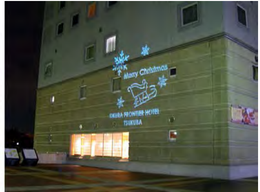
図2-1-85) 夜のホテルの外壁(つくば市、2006撮影)
