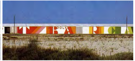
図2-1-25) ゴンドリー海軍造船所の陸側のファサード(フランス) *
