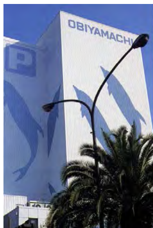
図4-2-12) 鯨のグラフィックのパーキング・タワー(高知市)*
