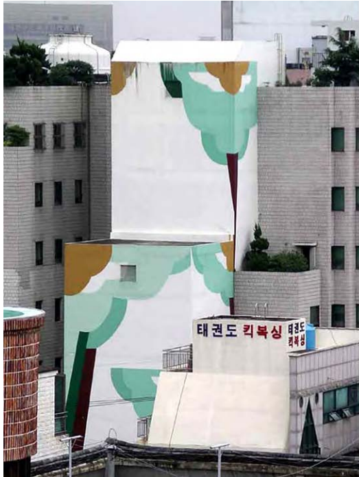
図2-1-35 (左)住宅街に隣接した総合病院のパーキング・タワー(釜山・韓国、2003撮影)
