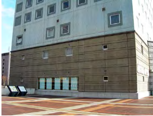
図2-1-84) 昼のホテルの外壁(つくば市、2006撮影)
