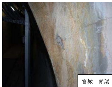
写真 2.4 シールドとう道の被災(左:クラック 右:一部剥離)
