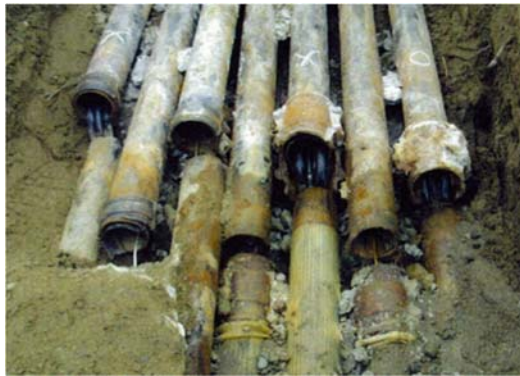
写真4.9 実際の地盤変状による管路被災
