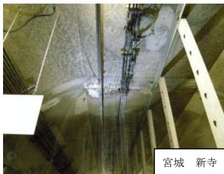
写真 2.5 山岳とう道の被災(左:漏水 右:クラック)
