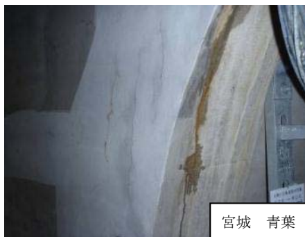
写真 2.4 シールドとう道の被災(左:クラック 右:一部剥離)
