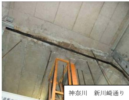
写真 2.3 開削とう道の被災 (左上下:剥離 右上:漏水 右下:M ジョイントにより漏水防止)
