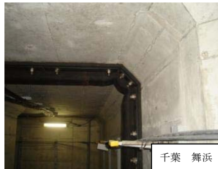
写真 2.3 開削とう道の被災 (左上下:剥離 右上:漏水 右下:M ジョイントにより漏水防止)
