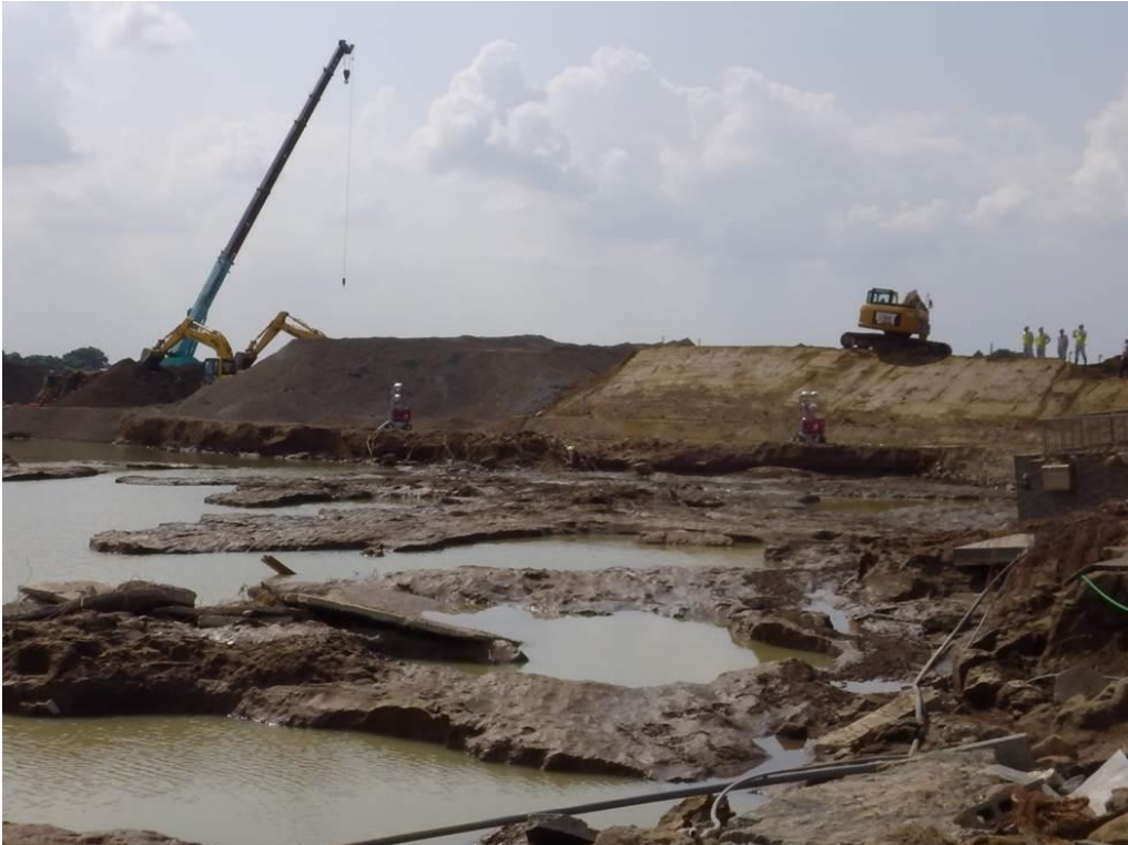
図 6-9 破堤点付近の深堀（9 月 15 日撮影）
