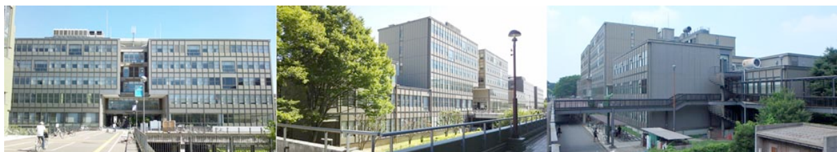
写真 2-1 5C 棟の外観
