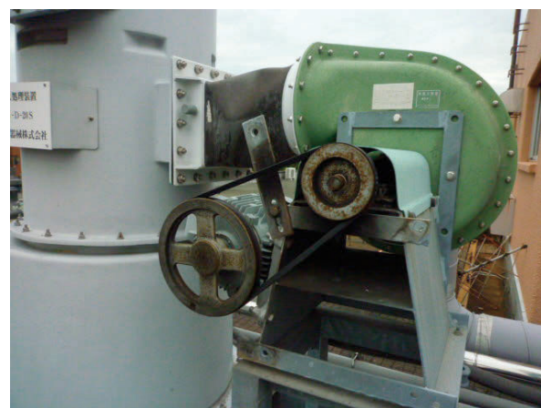
図6. ファンベルトの交換
