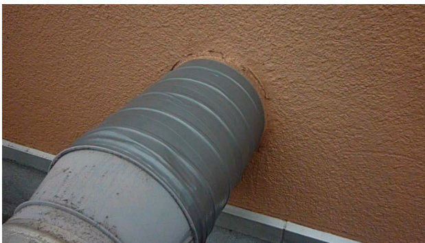
図 8. 補修後のダクト
